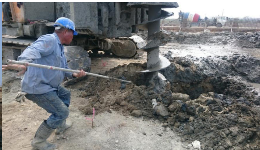
初次沖孔鑽掘，清除殘土，再鑽掘至設計深度，拉起鑽桿灌注水泥漿穩定液。
