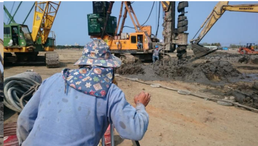
以水準儀檢測樁頂高程，並持續吊樁至不再下沉方可鬆脫鋼索，即施工完成
