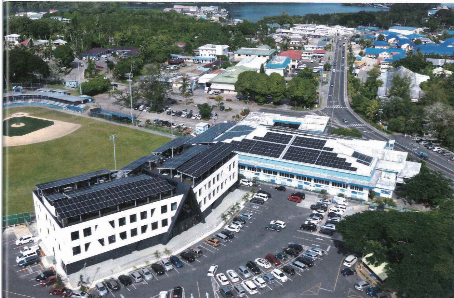
帛琉總統辦公室屋頂上的太陽能發電案場，出自全台最大太陽能統包工程公司聚恆科技之手。
