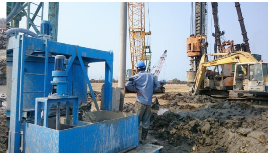
水泥拌漿設備系統，配合鑽掘注漿控制
