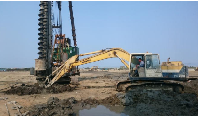
確認放樣點位，定位鑽掘。
