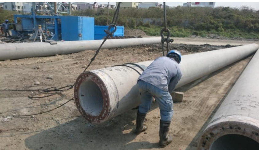
PC基樁吊掛作業，吊掛點至少離樁端1M
