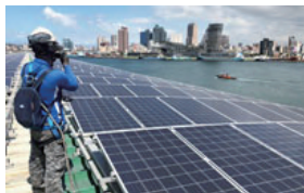
檢查模組 Inspection of Solar Module
