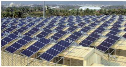
高捷北機電業/Kaohsiung Rapid Transit Corp.
